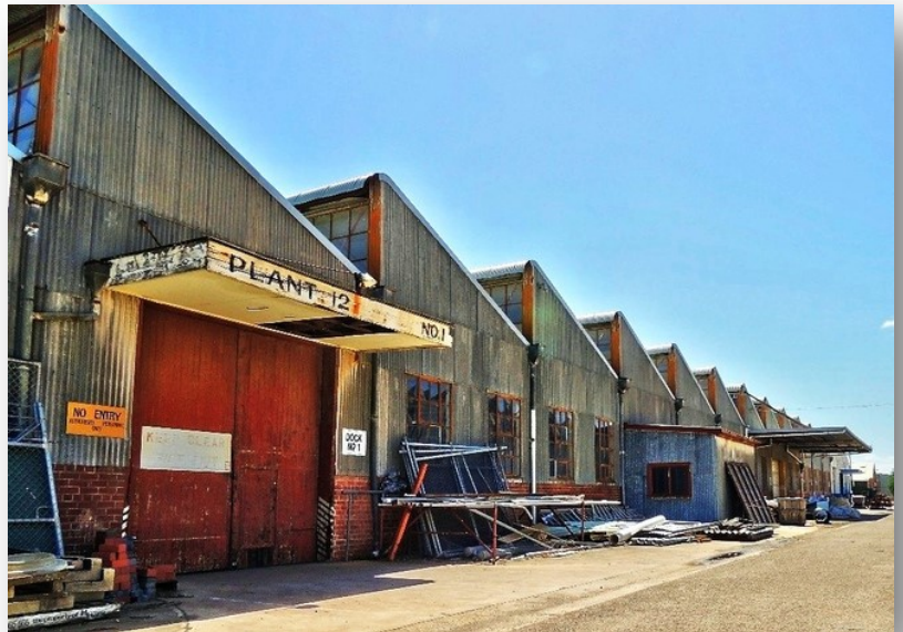
Cơ Sở Công Xưởng Sản Xuất Đạn Dược Finsbury sau này được sử dụng như một trung tâm phụ tùng hàng gia dụng Email, hình ảnh được sử dụng với sự cho phép của Dave Walsh
